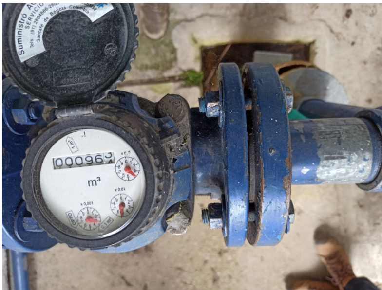
Foto 5. Medidor volumétrico instalado en el pozo pz-01-0010
